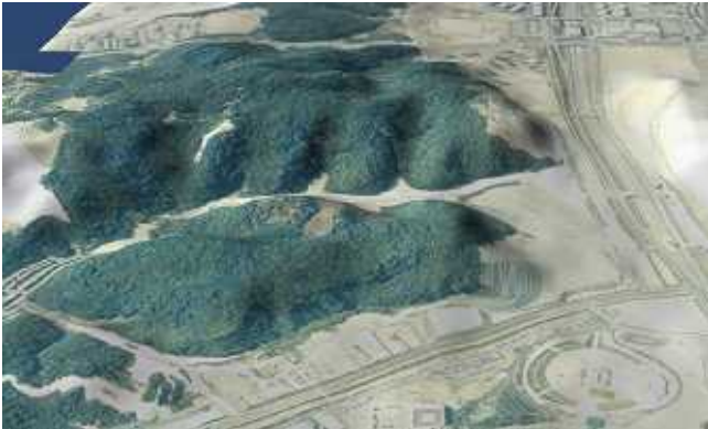
図9 造成工事中の風景
