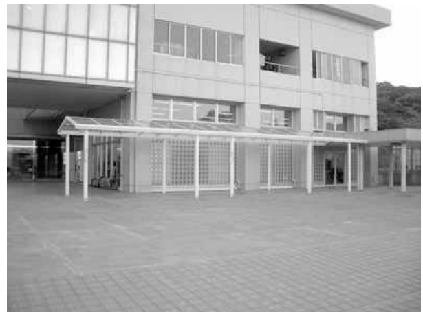
写真7 体育館前の渡り廊下とひさし
