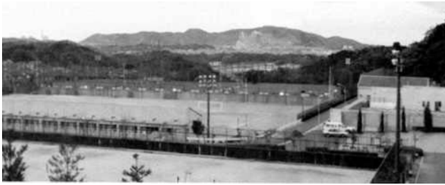
写真4 グラウンドの仮設住宅
