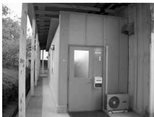
写真 10 高電圧実験棟増築部分
