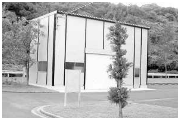
写真 12 電気工学科仮設実験室
