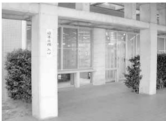
写真 9 日本庭園外部入口設置
