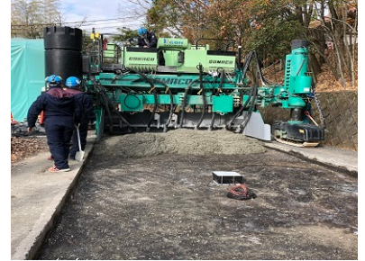
繊維補強コンクリート舗装の施工の様子
