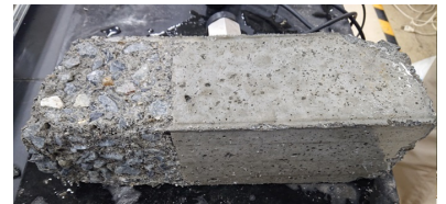
凍害を受けたコンクリート供試体
