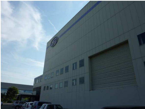
写真 1 米原風洞技術センター
