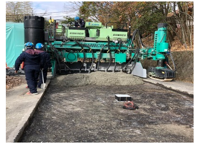
繊維補強コンクリート舗装の施工の様子
