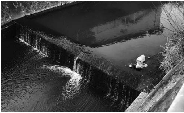
図1 落差工 (ST.2 付近)
