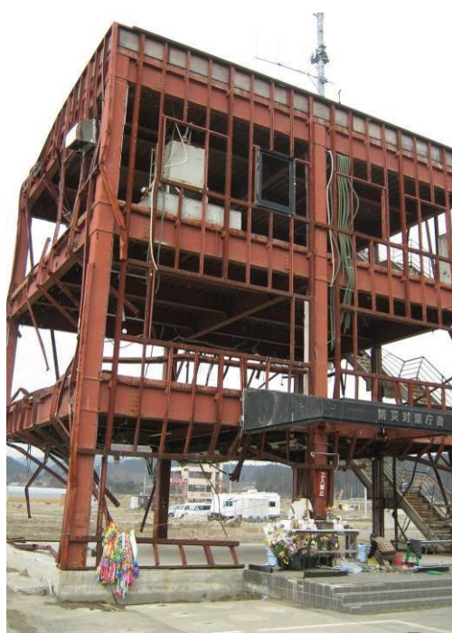
写真2 南三陸町 防災対策庁舎
