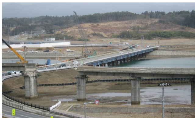
写真8 津波で欠落した橋梁
