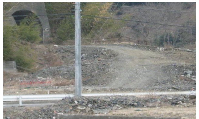
写真 26 トラックが利用する旧 JR のトンネル
