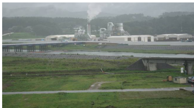
写真9 がれき処分施設（平成25年度10月に撤廃）
