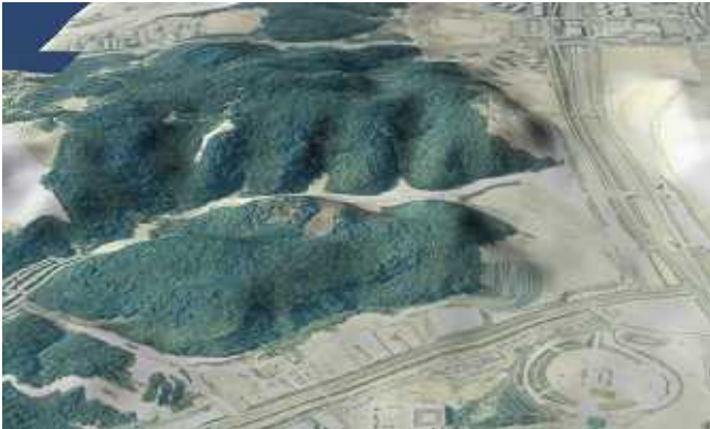
図9 造成工事中の風景
